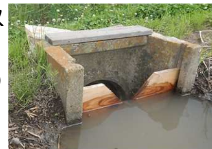
田んぼダムの調整板の設置
