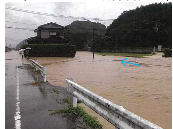
写真 2.8 令和元年 8 月洪水による浸水状況 (武雄川：淵の尾浄水場付近)
