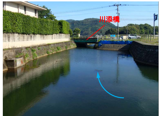
写真 5.2 川添橋上流左岸から 川添橋（国道 34 号）を望む
