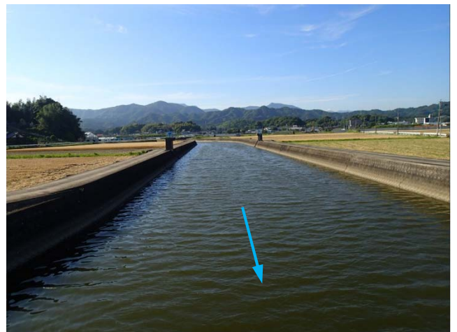
写真 2.16 舟津橋から川添川上流を望む
