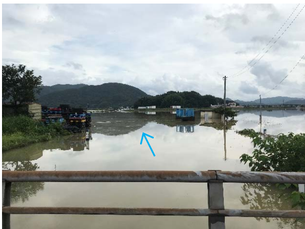
写真 2.7 令和元年 8 月洪水による浸水状況 (川添川：国道 3 4 号より下流を望む)
