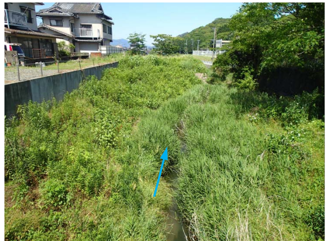
写真 5.4 第一淵の尾橋から武雄川下流を望む
