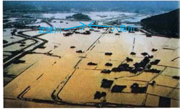
写真 2.2 平成 2 年 7 月洪水による浸水状況 (武雄川合流点を望む)
