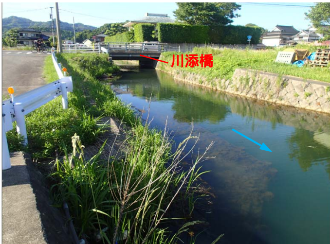
写真 5.1 川添橋下流右岸から 川添橋（国道 34 号）を望む
