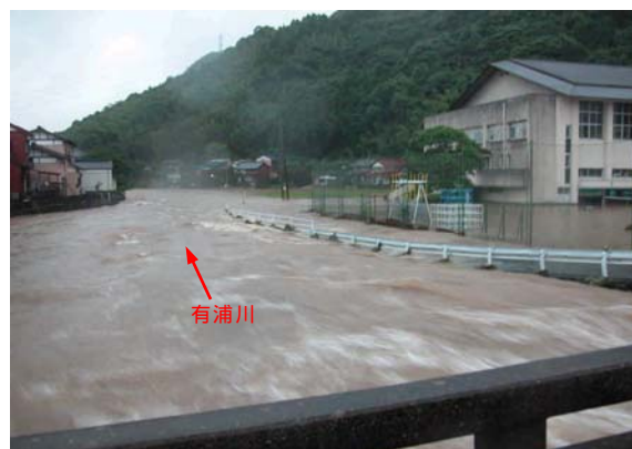
写真 4 学校橋より下流の状況
