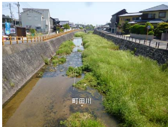
写真 5.3 長松橋から下流を望む
