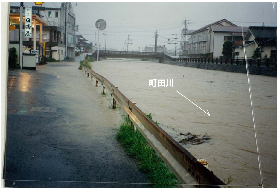
写真 2.2 平成 10 年 5 月洪水による氾濫状況（町田川：唐津市上町田橋付近下流）
