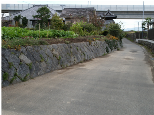
写真－1 田出島集落（ じょうふく 浄福寺付近）の屋地盛
