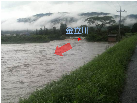
写真 2.5 平成 21 年 7 月洪水による堤防決壊状況 (金立川：巨勢川合流点付近)
