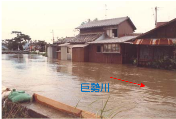
写真 2.1 昭和 55 年 8 月洪水による氾濫状況 (巨勢川：学校橋付近)
