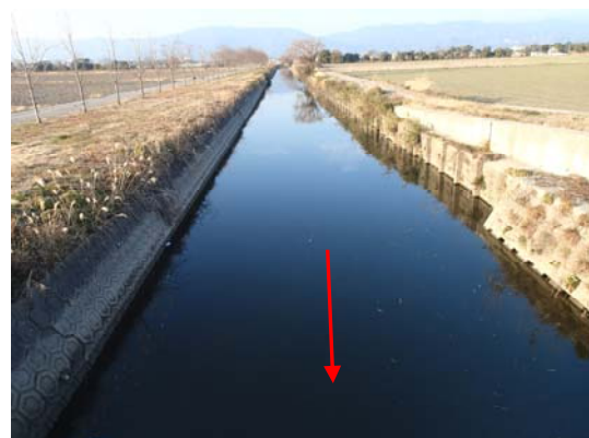
写真 5.8 焼原橋より上流を望む
