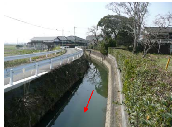
写真 5.10 折地橋から上流を望む
