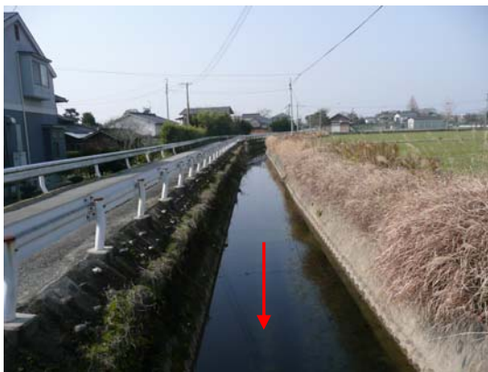
写真 5.9 観音橋から上流を望む
