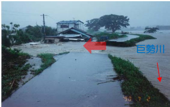
写真 2.3 平成 2 年 7 月洪水による堤防決壊状況 (巨勢川：念仏橋付近)
