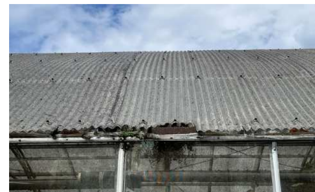
図3.屋根（一部）写真
