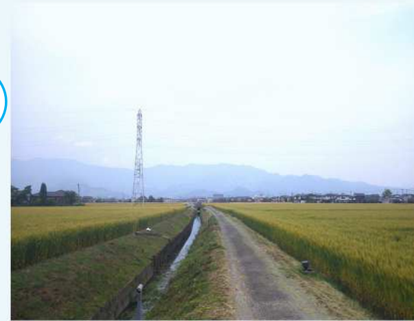
基盤整備工事施工後
