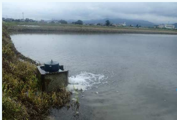
基盤整備工事施工後
