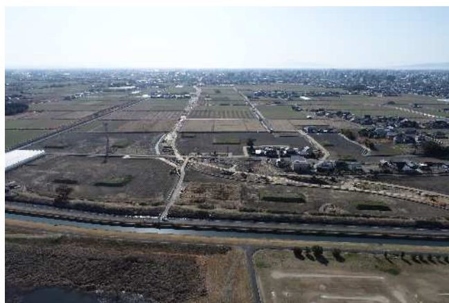
基盤整備工事施工前
