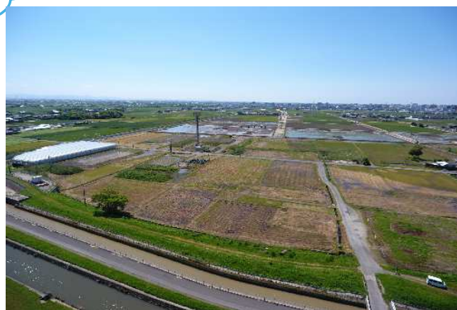
基盤整備工事施工後
