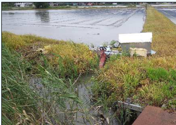
基盤整備工事施工前
