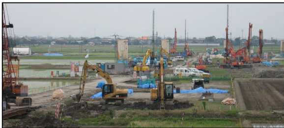
嘉瀬川堤防(東側)から嘉瀬町を見た地盤改良の現場
