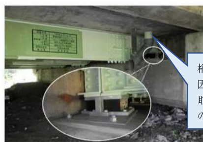
対策内容：主桁当て板補修，塗装塗替， 支承取替，排水施設取替
