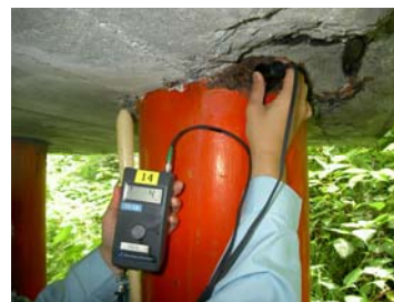
超音波板厚計による鋼管厚さ計測
