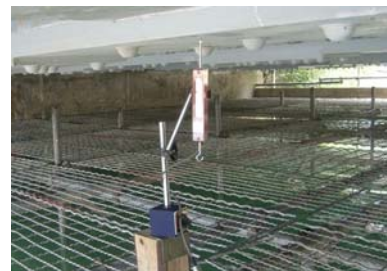
写真 3-1-6 変位計によるたわみ計測例
