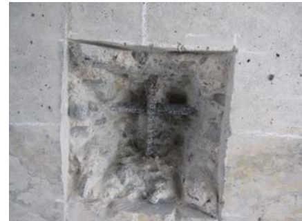
写真 3-1-15 鉄筋径調査事例
