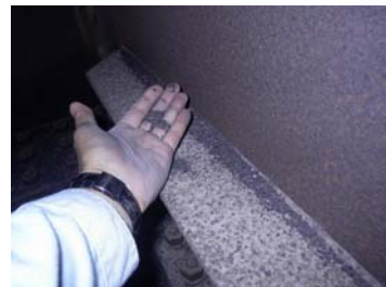
写真 3-1-31 耐候性鋼材の錆外観調査例
