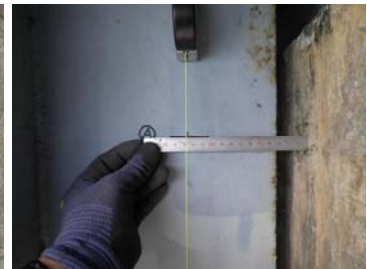
下げ振りによる傾斜計測例
