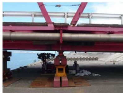
写真 2-2-2 仮ベント支持
