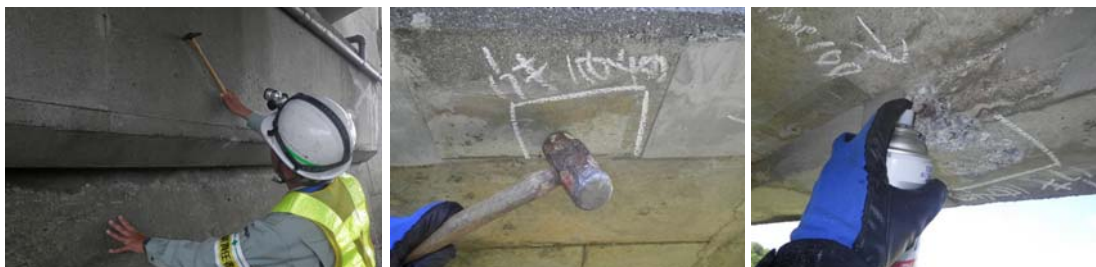
打音調査状況
