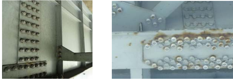
写真 4-2-1 落下防止キャップ設置状況
