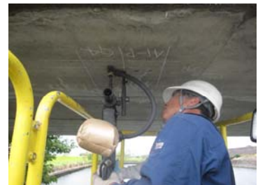
写真 3-1-20 ドリル法事例
