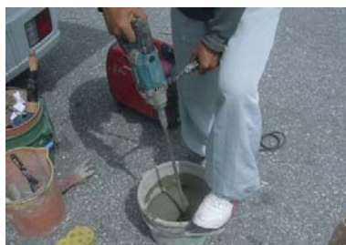
写真 3-1-8 断面修復材の混練り
