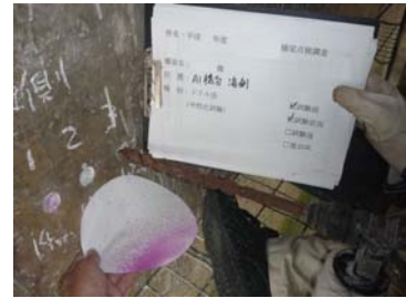
写真 3-1-19 ドリル法事例
