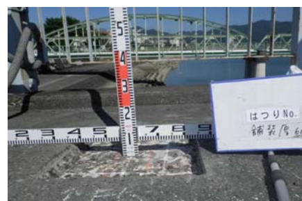
写真 3-1-16 舗装厚調査事例
