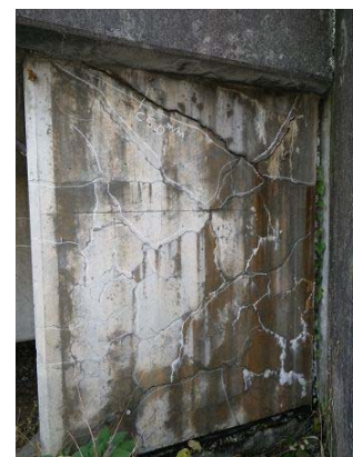
写真 3-1-21 PC 橋の ASR 事例
