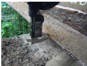
ノギスによるフランジ厚計測
