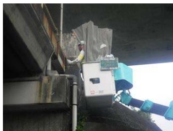
写真 3-1-2 飛散防止措置例
