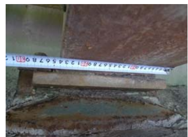
コンベックスによる計測例
