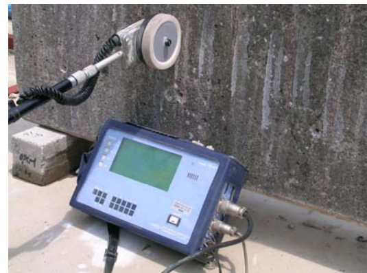
写真 3-1-17 自然電位法計測事例
