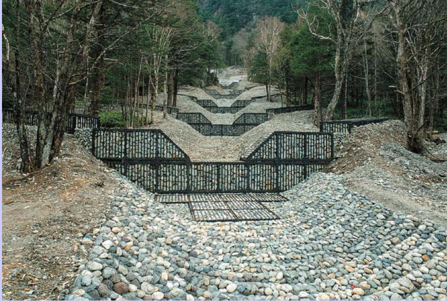
中千丈床固工（長野県）
