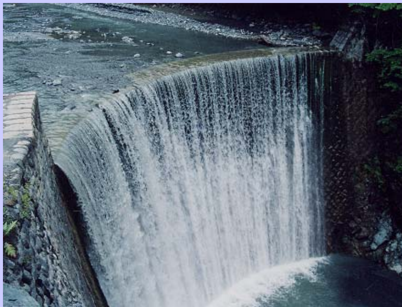
上蔵砂防えん堤（天竜川上流河川事務所）
