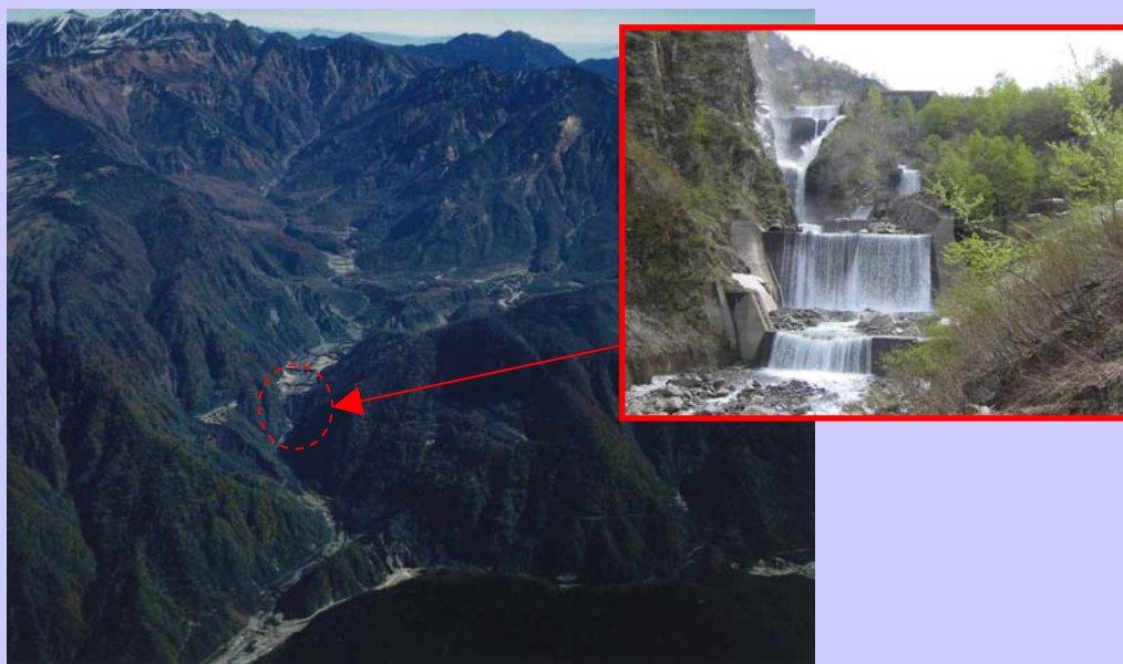
白岩砂防えん堤（立山砂防事務所）
