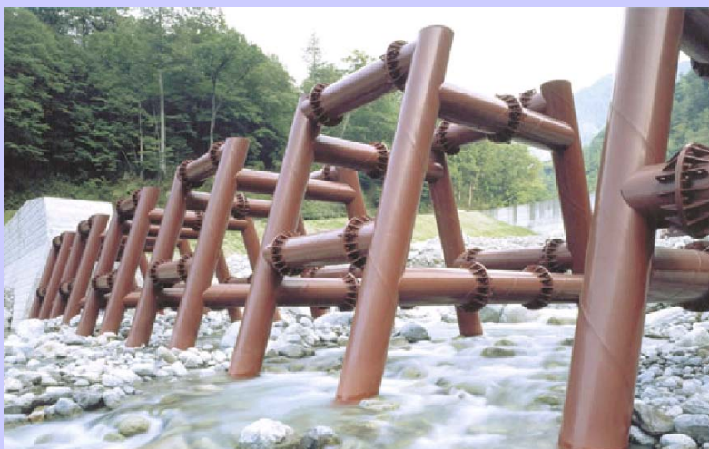
滑川砂防えん堤（多治見砂防国道事務所）
