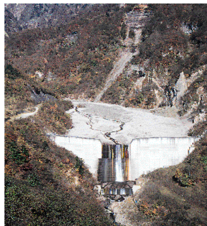
日向砂防えん堤 (日光砂防事務所)
