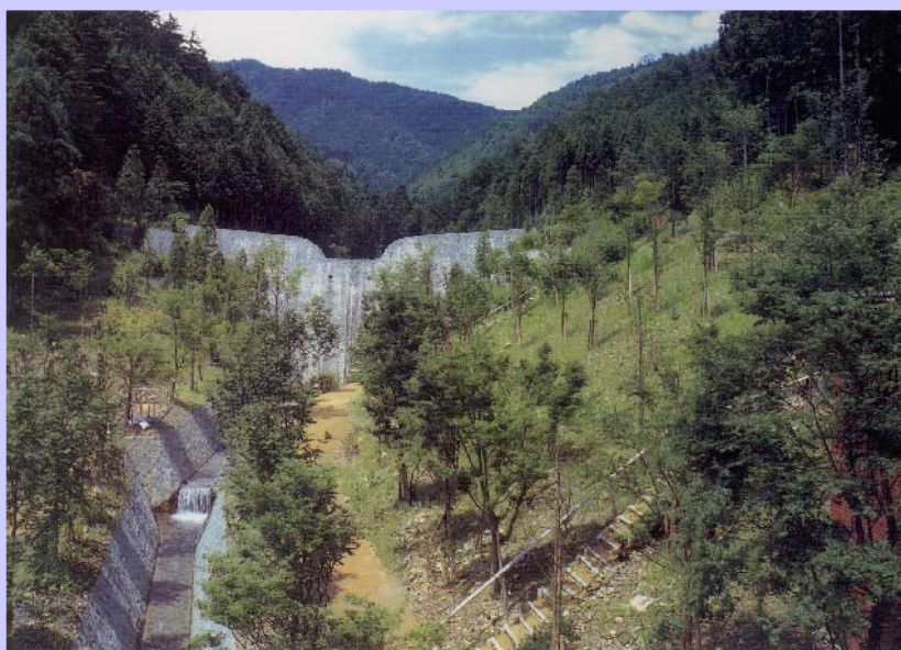
西の谷川えん堤（京都府）
