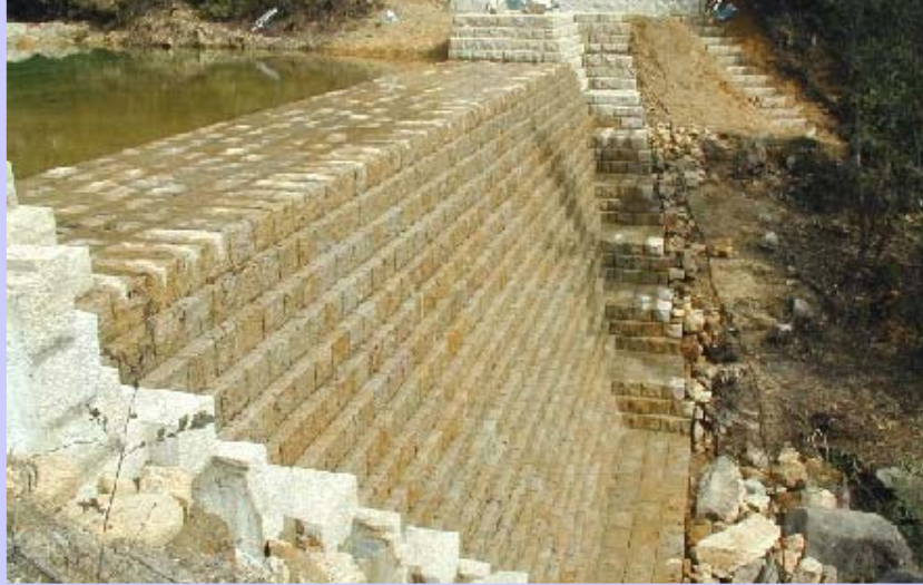
迎不動えん堤 (琵琶湖河川事務所)
