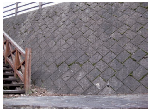
陰影をつけた表面処理により、圧迫感が軽減されている。(神崎市)
