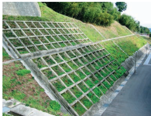
法枠工の枠内を緑化することにより、圧迫感が軽減され、周辺景観と調和している。(みやき町)
