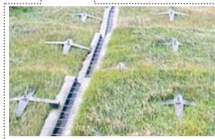
法枠等が目立たないような工法の活用と緑化により、周囲景観と調和している。(大分県蒲江町)
