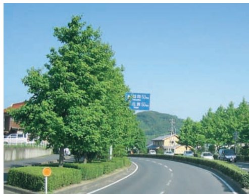
防護柵の代替機能となる緑地帯により、良好な景観と安全性を確保している。(唐津市)
