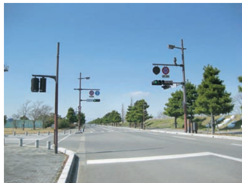
信号、照明施設、標識の共架により、景観上の繁雑さの軽減につながっている。(佐賀市)
