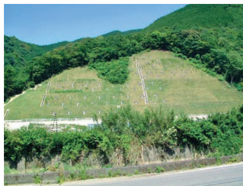
法枠等が目立たないような工法の活用と緑化により、周囲景観と調和している。(大分県蒲江町)
