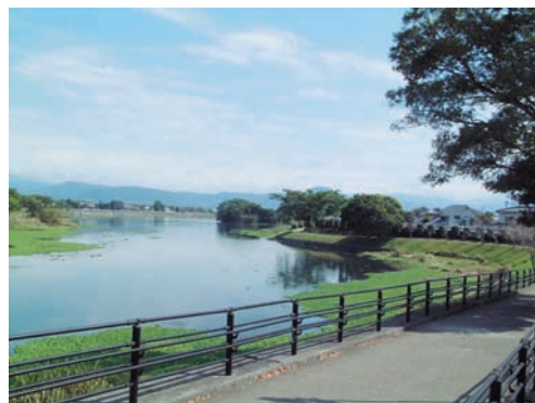
防護柵を低明度の色彩、シンプルなデザインとし、眺望の阻害とならないよう配慮されている。(熊本市)
