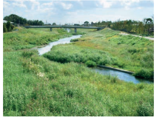
緩勾配護岸とし、植生への配慮及び周辺景観との調和を図っている。(吉野ヶ里町)
