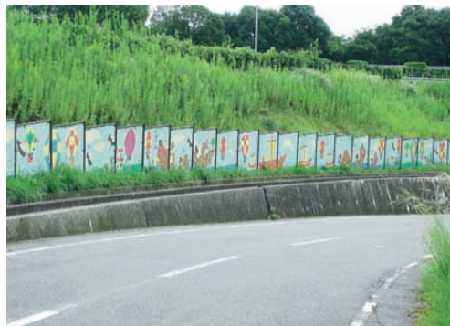
過度な地域性の表現のため、防護柵が目立っている。
