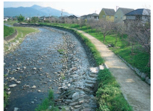
水際に近づきやすくし、周辺を憩いの場として一体的に整備している。(多久市)
