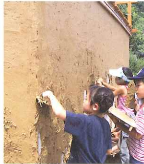
小城市掬水庵での子どもを対象とした壁塗り体験
