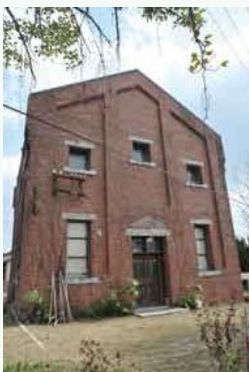
住宅街の中に忽然と現れる赤煉瓦造りの大町煉瓦館。馬車に耐えた趣のある外観で、壁所に残された硝子(がし)の跡が、変電所の名残りと伝える。中では大町煉瓦館の活動の様子などを展示。
