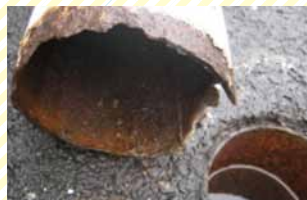
ポール看板の倒壊
