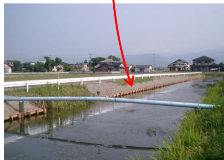
【木柵工による護岸整備】
