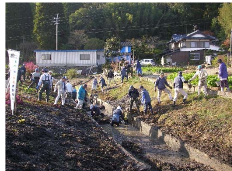
【水路内の泥上げ】
