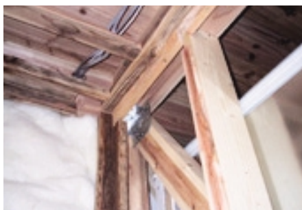
柱と筋かいの金物接合状況
