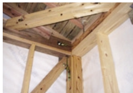
柱・はりの金物接合状況
