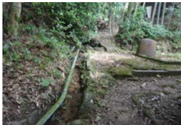
図3-1-14 落ち葉や土砂が堆積した水路
