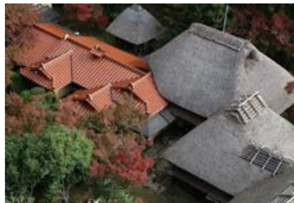
図3-1-27 屋根(雨漏りを生じやすい谷部分)
