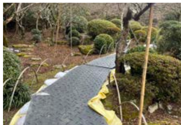
図3-2-15 指定地内園路の養生
