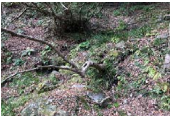
図3-1-22 園路石段上に傾斜した樹木
