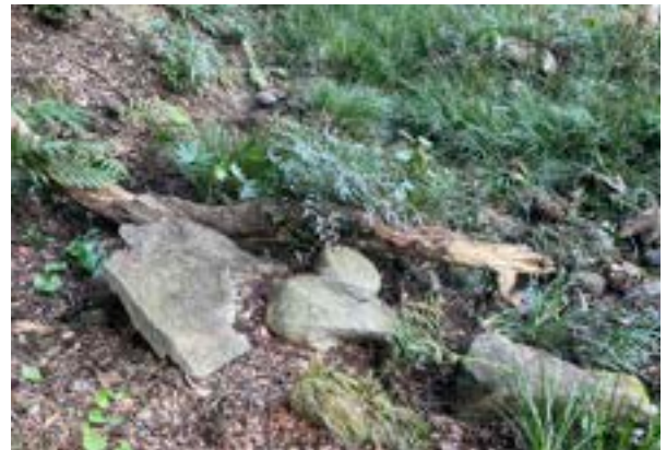
図3-1-10 倒木により破損した山灯笼
