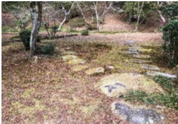
図3-1-3 苔の付着、不陸、埋没がみられる飛石
