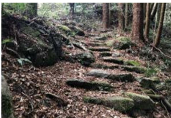
図3-1-5 土砂等堆積、傾斜が生じている石階段
