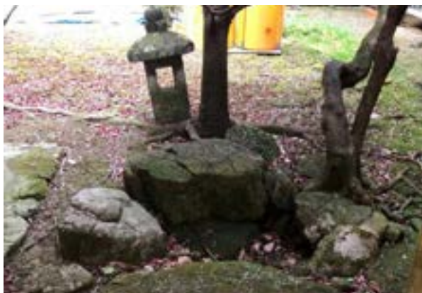
図3-1-11 燈障りの木（サカキ）の成長により傾斜した灯笼
