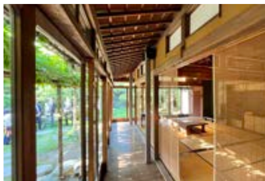
図6-1-1 鉄骨補強（旧小澤家住宅）
