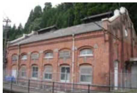
図 2-3-6 広滝第一発電所
