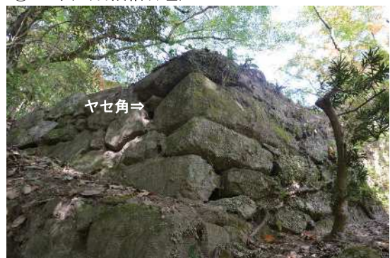
⑥ 05-06 面隅角部 ([ 下段 ] 池南側石垣)
