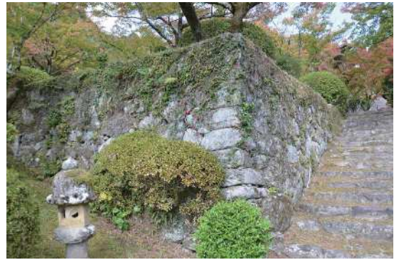
② 03-04 面隅角部 (石段袖石垣)
