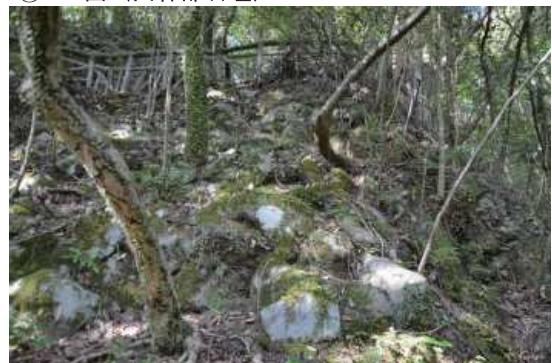
⑧ 28 面（山林部石垣）
