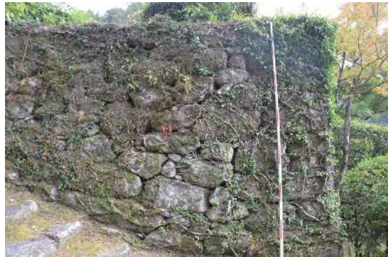
③ 01 面 (石段袖石垣)
