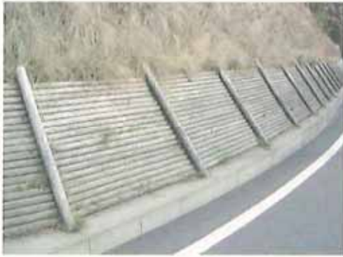
施工後7年経過（表面に苔の付着などもあるが耐久性は維持している。）
