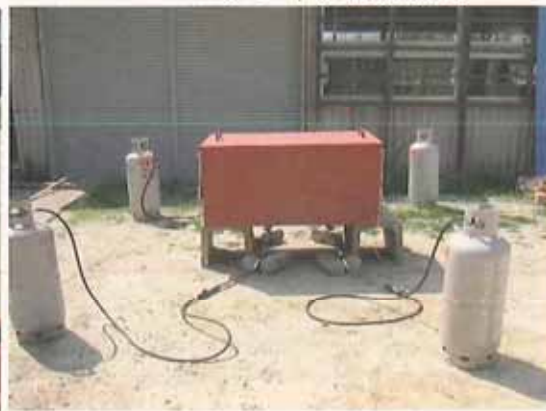
パラフィン加熱状況
