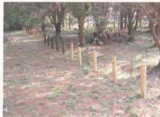
廃油加熱杭設置状況
