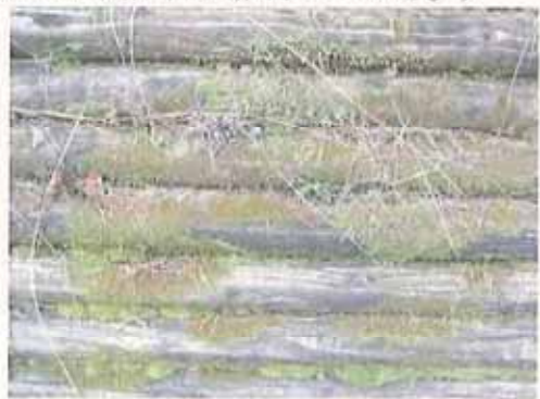
施工後7年経過（表面に苔の付着などもあるが耐久性は維持している。）
