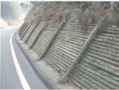
施工後7年経過（表面に苔の付着などもあるが耐久性は維持している。）
