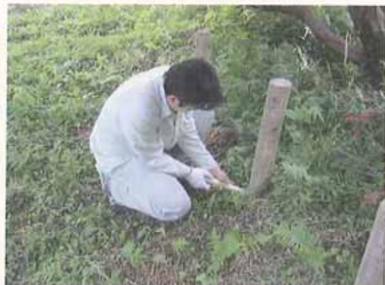
ピロディン調査状況
