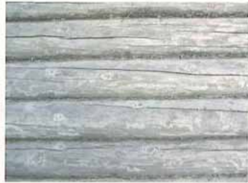
施工後7年経過（表面に苔の付着などもあるが耐久性は維持している。）
