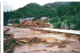
下流域での被害
