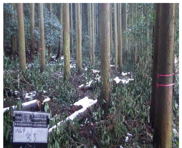
整備後（服巻地区）
