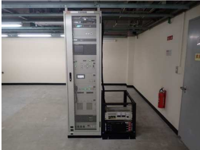
(新八幡岳中継所の受診制御装置)
