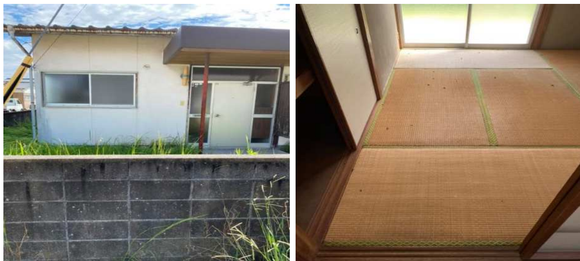
（左：外観／右：1151号室の部屋内 令和4年9月 包括外部監査人補助者撮影）
