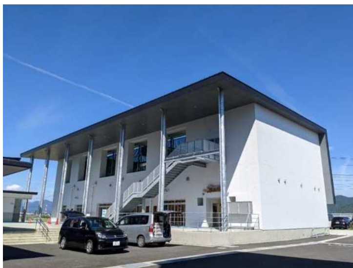
(写真 1：神埼高校武道場 外観 佐賀県より入手)
