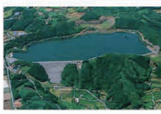
うしろがわ 後川内ダム 唐津市後川内
