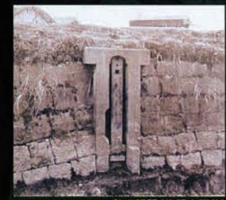
昔の樋門(佐賀市天祐)
