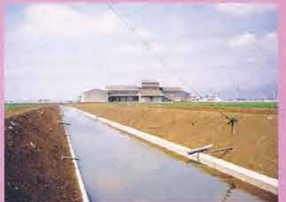
用排水路: 曲がりくねったクリークは、水を運んだり溜めたりしやすいように整備されました。
