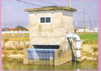
ポンプ: 昔の足踏み式の水車に替わって、電気力で用水路から水をくみあげて田んぼに送水することができます。
