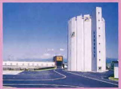
佐賀揚水機場: 筑後川の水をポンプでくみ上げる施設で、水は幹線水路を通り、各地の分水口からクリークに流れて田畑を潤します。
