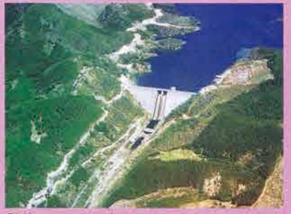
北山ダム: 嘉瀬川の水をせき止め、安定した農業用水を供給することができるようになりました。
