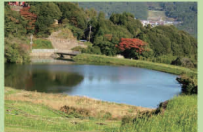
山谷大堤(有田町山谷切口地区)
