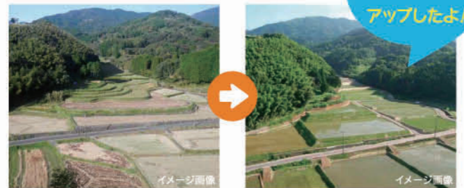
〈整備前〉 〈整備後〉
