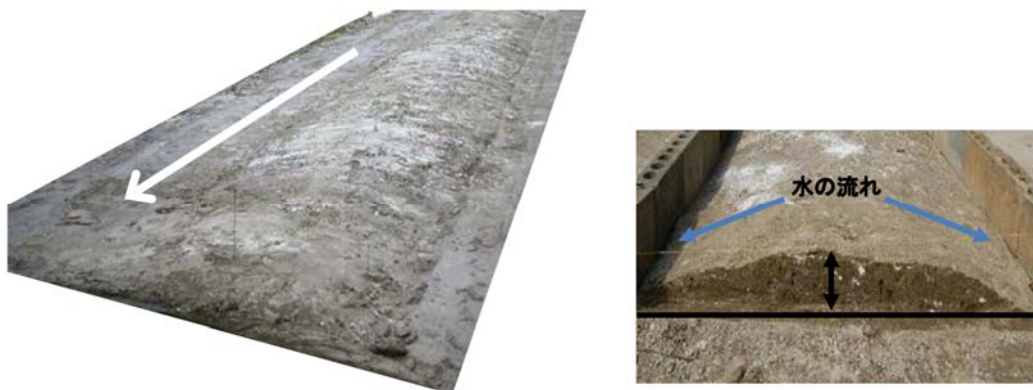
図3 整地後の畝下部の傾斜
