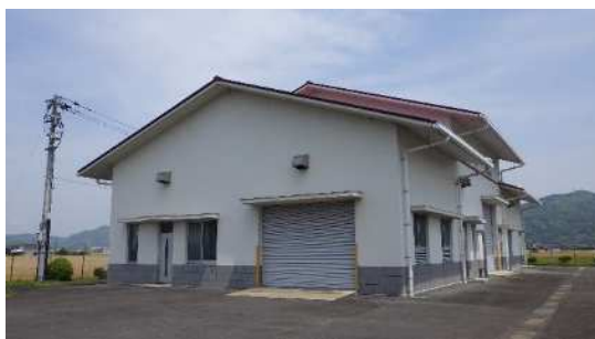
[資源循環施設] (嬉野市五町田・谷所地区)
