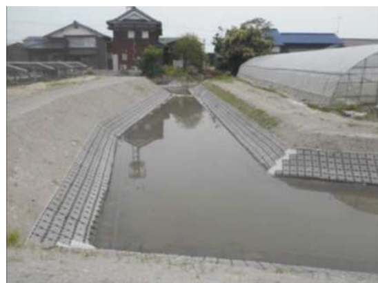
[集落排水路整備後]
