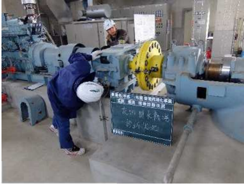
[排水機場点検状況]
