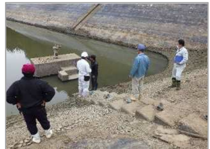
[ため池点検の様子]
