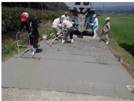
[農道のコンクリート舗装]
