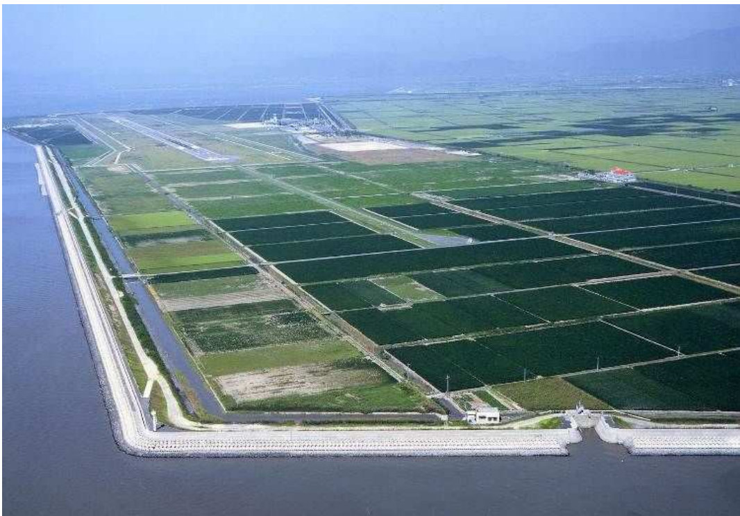
〔補強された堤防(南川副地区)〕
