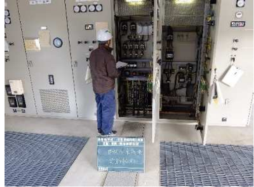
[電気設備点検状況]
