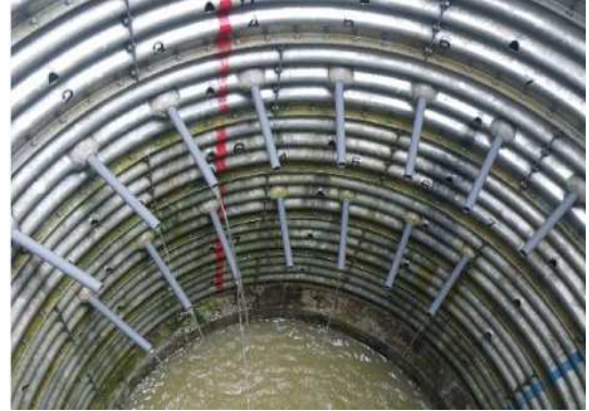
〔集水井内の水抜き状況〕
