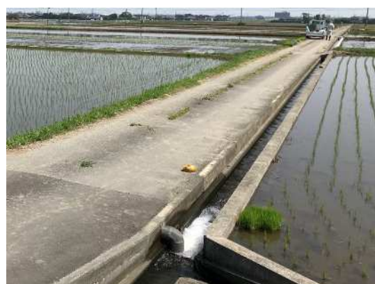
[分水口からの給水状況]
