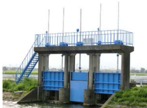
[制水門補修後]
