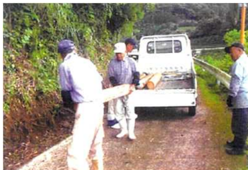
[直営施工による農地保全]
