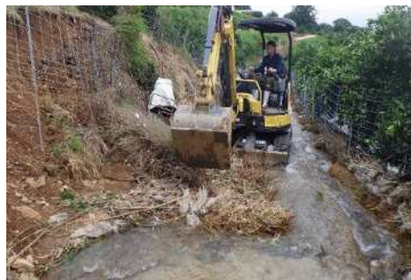
[農道の異常気象後の応急措置]
