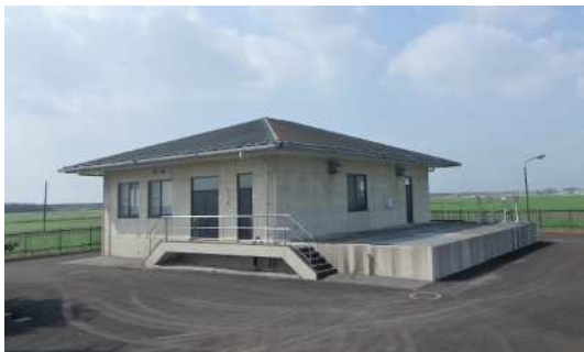
[農業集落排水施設の外観] (佐賀市江戸地区)
