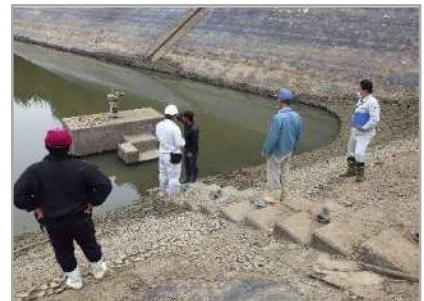
[ため池点検の様子]
