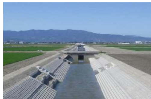
[法面保護による崩壊防止]
