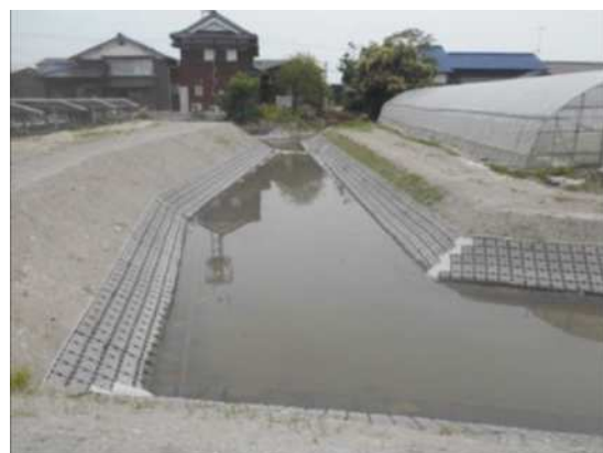
[集落排水路整備後]
