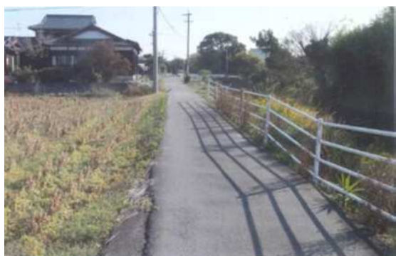
[集落道路整備前]
