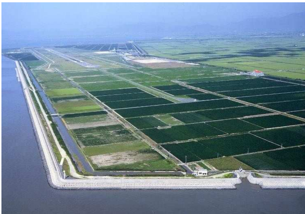
〔補強された堤防(南川副地区)〕
