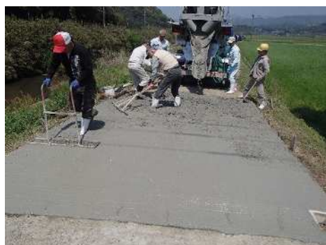
[農道のコンクリート舗装]
