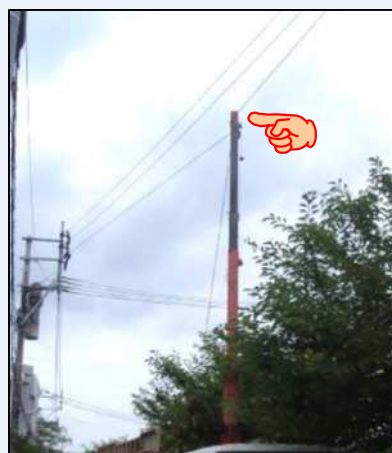
【クレーンが高圧線に接触】
