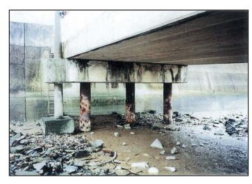
基礎部が腐食し、道路(橋梁)破損の 恐れがあった。
