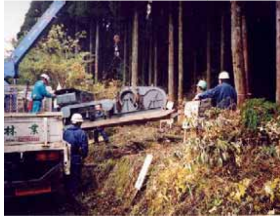
資機材の搬入
