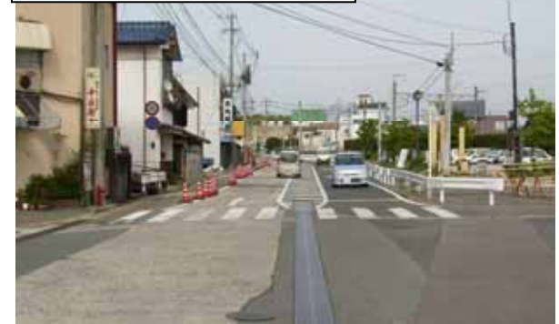
起点暫定舗装部
