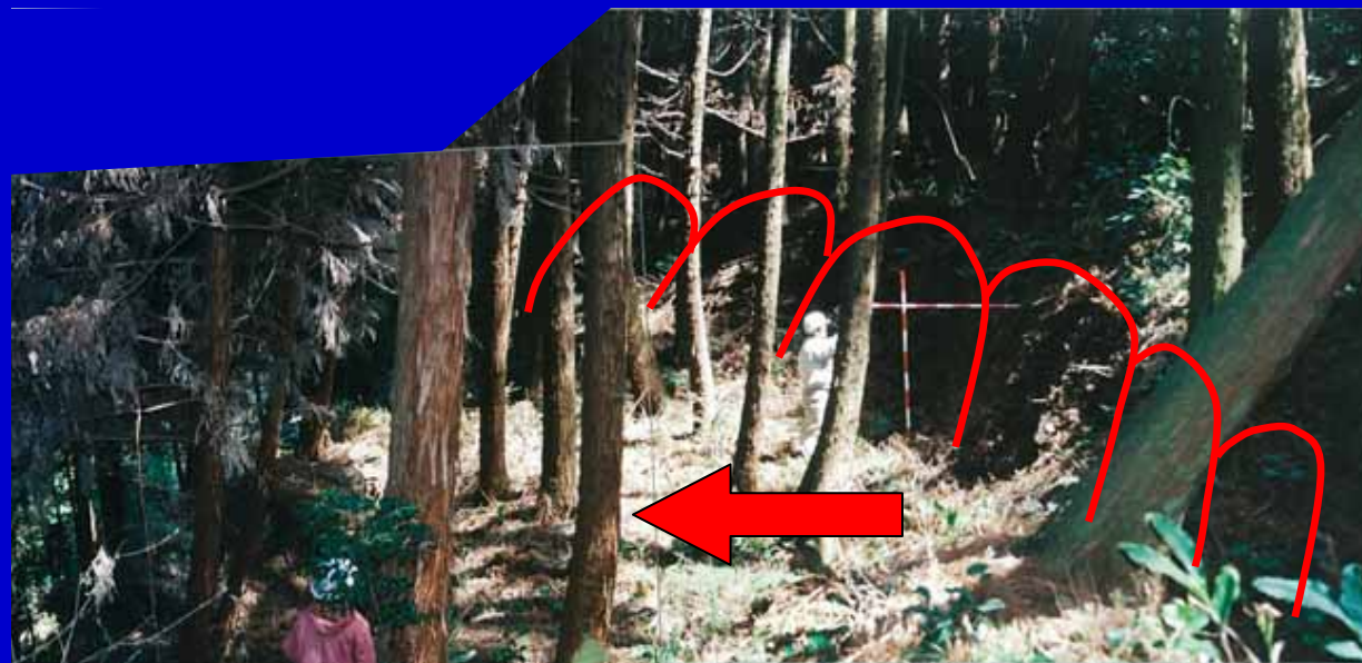
地すべり末端部の地表面陥没状況
