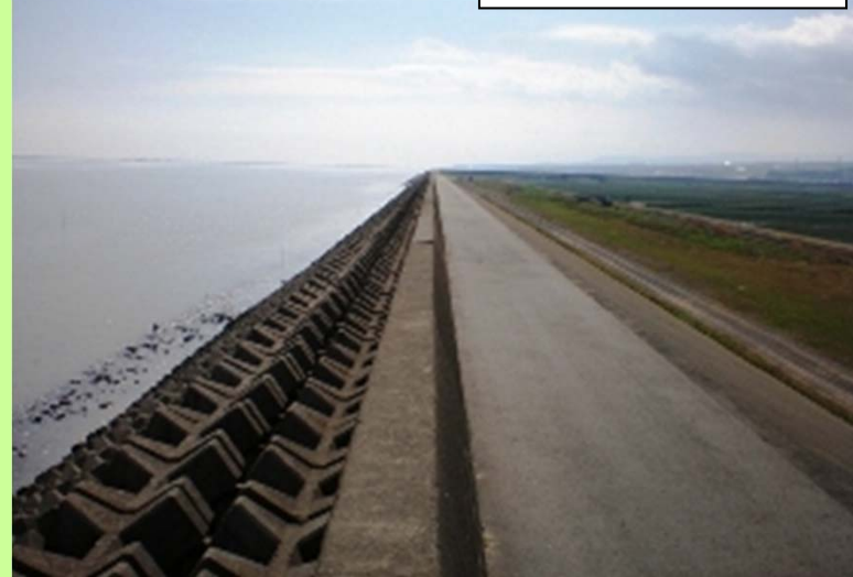
整備状況(七浦地区)
