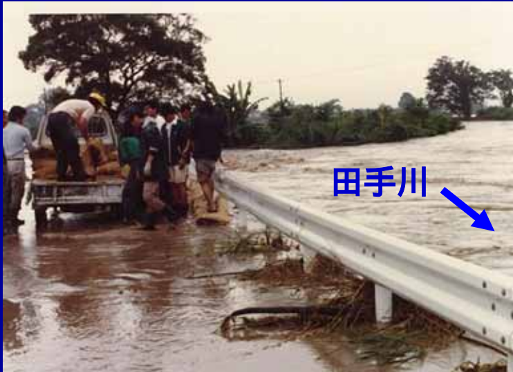
(昭和57年7月 出水状況)(千代田町下板)
