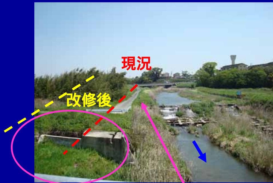
河原橋(国道385号) 直上流
