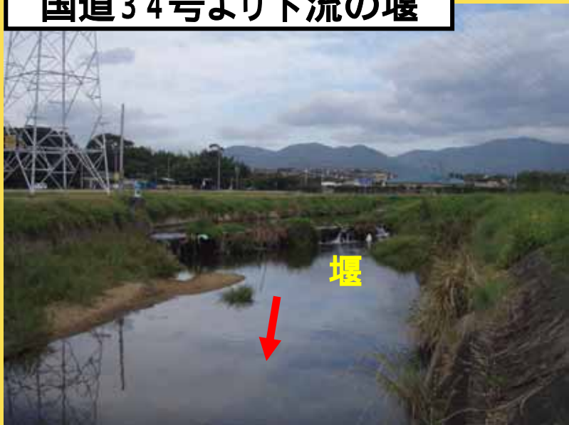
既設の堰があり、河川断面が狭小
