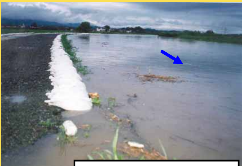
(国道264号より上流)
