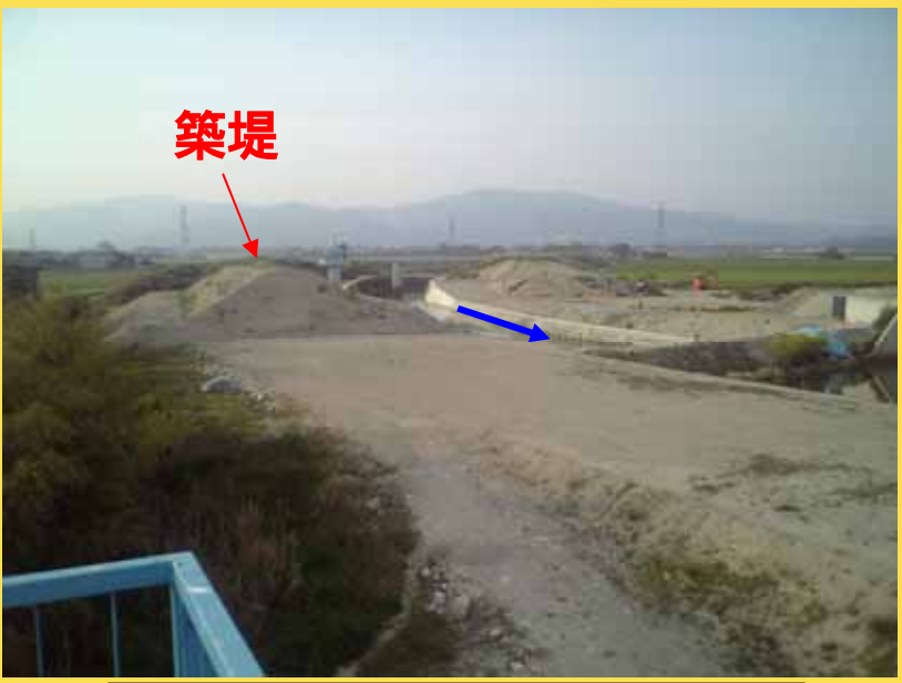
整備状況(放水路区間)
