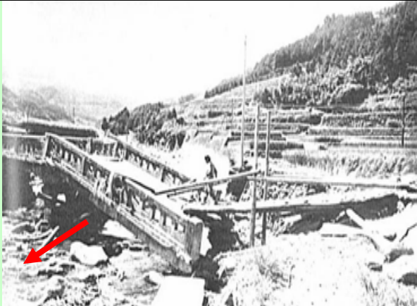
昭和51年9月洪水による藤ノ瀬橋の流失 (県道奥山鹿島線) 出典:「鹿島市災害誌」
