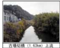
古場切橋 (1.63km) 上流
