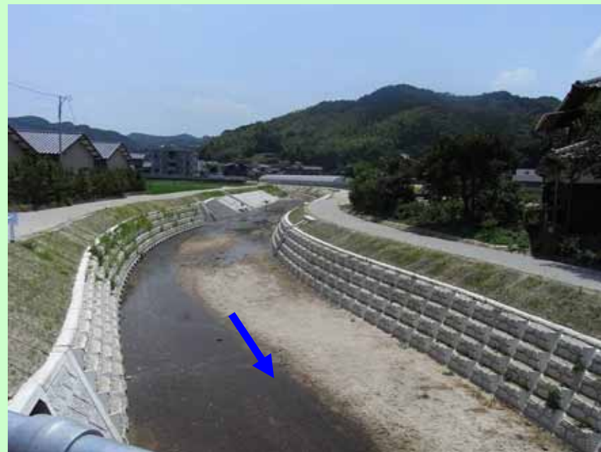
山口川0K200地点(前田橋)より上流を望む
