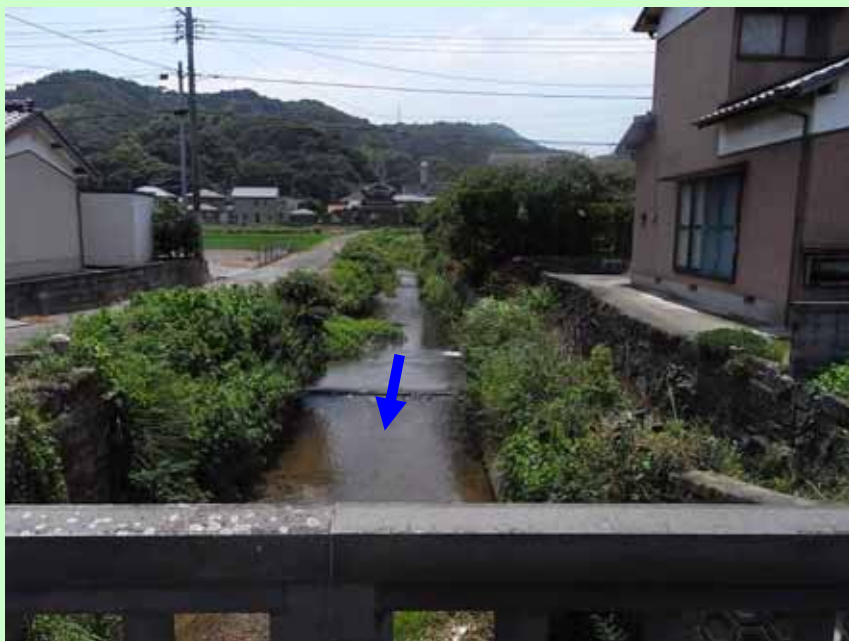
2K589地点(中島橋)より上流を望む
