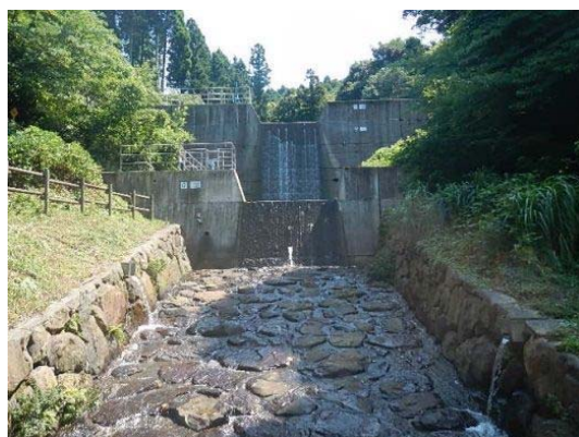
治山ダム(佐賀県で管理)
