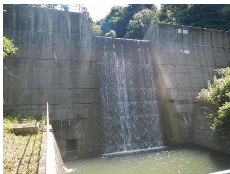
貯水型治山ダム
