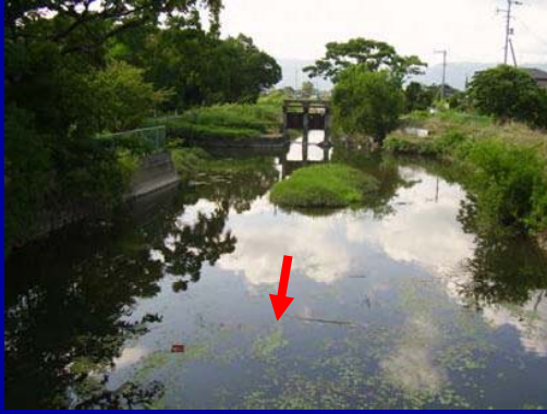
【中池江川】(姉川橋上流区間)
