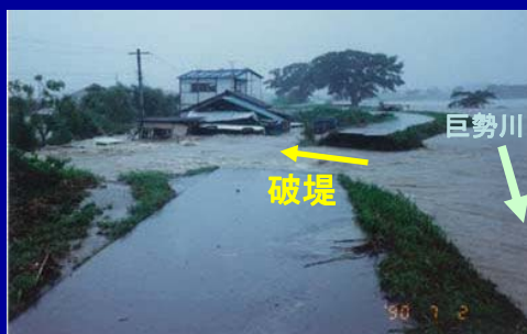
【巨勢川上流破堤状況】
