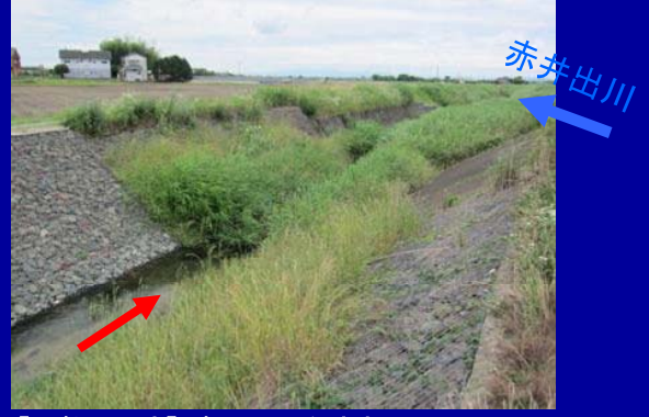
【巨勢川上流】(赤井出川合流点区間)
