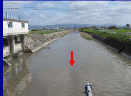
【八田江】(古江湖排水機場より上流区間)
