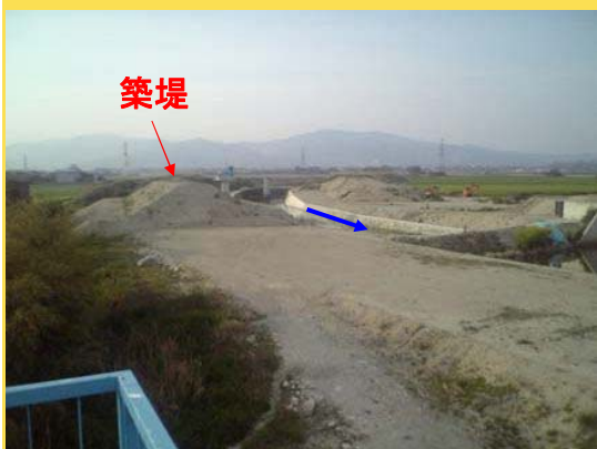
施工状況(放水路区間) (※H19~H20)
