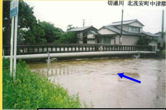
県道北茂安三田川線(中津隈橋) (みやき町中津隈)
