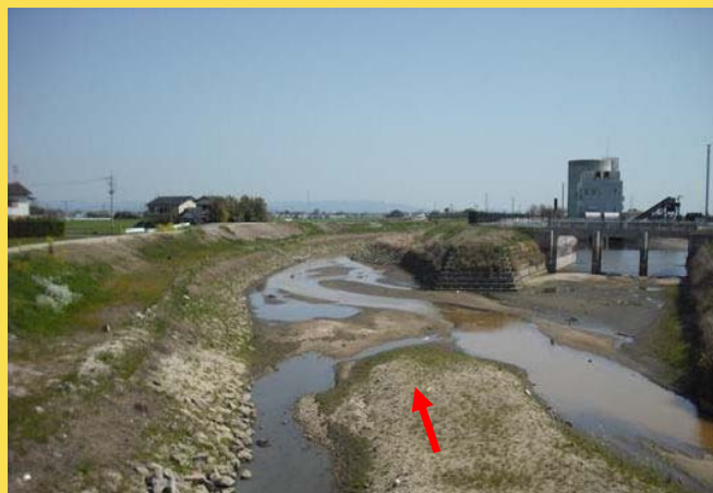
改修後の河川
