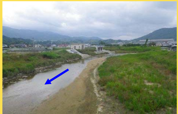
【浜崎橋(0k530)より上流を望む】
