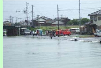
平成24年 台風16号: 高潮による浸水発生 (鹿島市浜町地内)
