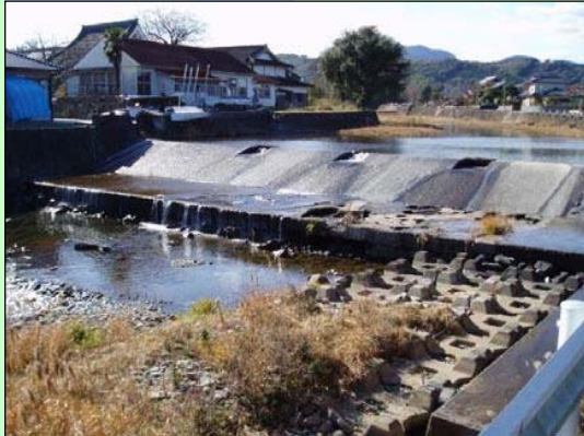
改修前(固定堰)
