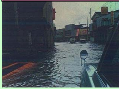
昭和57年出水状況 (鹿島市浜町地内)
