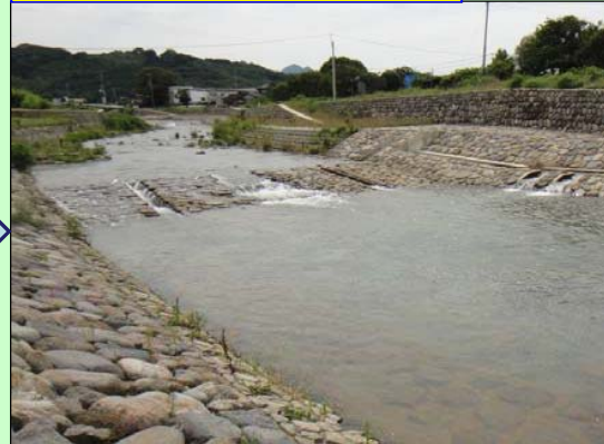
改修後(緩傾斜型落差工)
