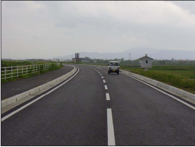
起点側から終点側を望む (改良済箇所)
