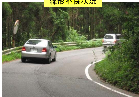
線形不良状況
