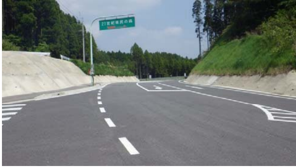
中間部から起点側を望む (改良済箇所)
