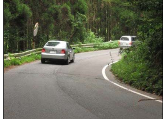
中間部より終点側を望む (未改良区間)
